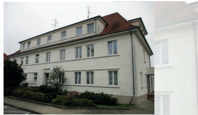
Das alte Betriebsstellengebäude
